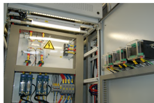
Рис. 3. Защита от прикосновения к токоведущим частям
