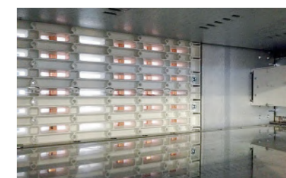
Рис. 4. Защита от прикосновения при извлеченном модуле
