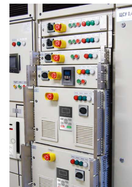
Рис. 17. Пример шкафа ШЛ с выдвижными модулями ВУМ
