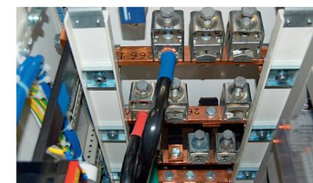
Рис. 17. Шинная сборка с клеммными зажимами FIBUS<sup>®</sup>
