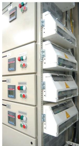
Рис. 13. Подключение кабеля к фиксированным модулям при виде внутреннего разделения 4b
