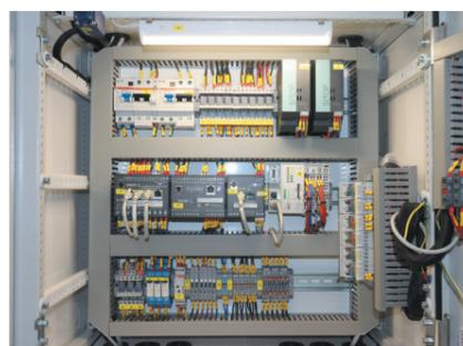
Рис. 19. Пример размещения вторичного оборудования в шкафу ШС
