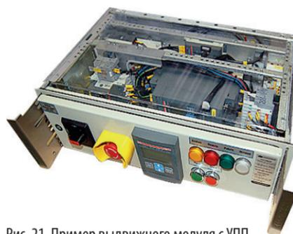
Рис. 21. Пример выдвижного модуля с УПП
