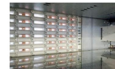
Рис. 4. Защита от прикосновения при извлеченном модуле
