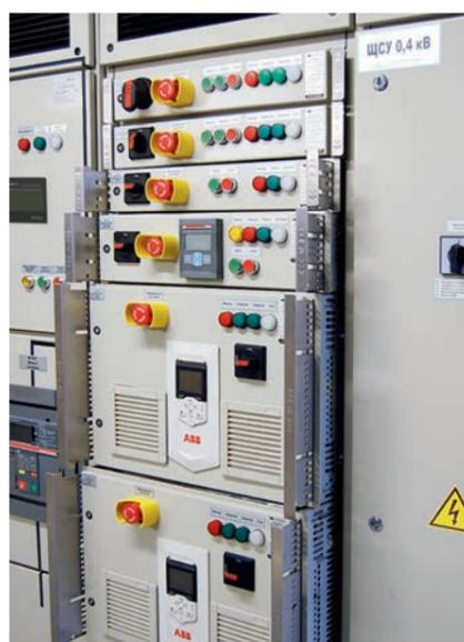
Рис. 19. Пример шкафа ШЛ с выдвижными модулями ВУМ-2
