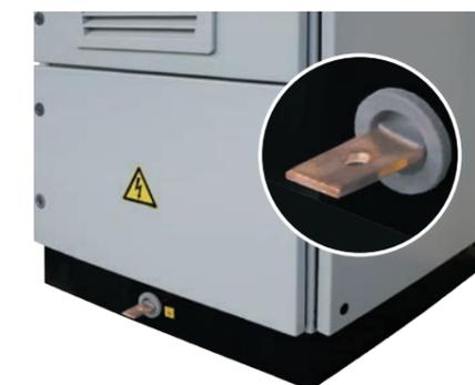
Рис. 41. Вывод шины PE
