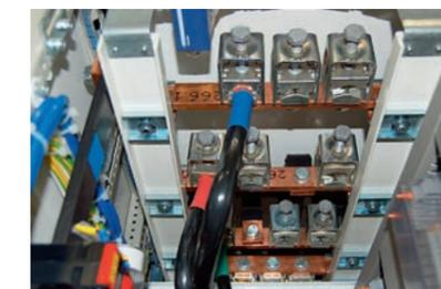
Рис. 14. Шинная сборка с клеммными зажимами FIBUS®
