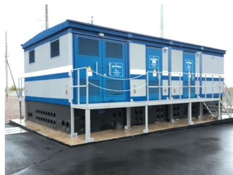
Рис. 6. Пример БКТП-ELM-10 (6)/0.4 в железобетонном здании
