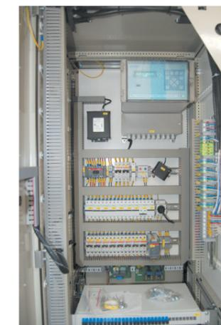
Рис. 31. Шкаф автоматизированной системы коммерческого (или технического) учета с устройством сбора и передачи данных
