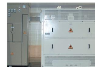
Рис. 8. Подключение РУНН к трансформатору жесткой ошиновкой
