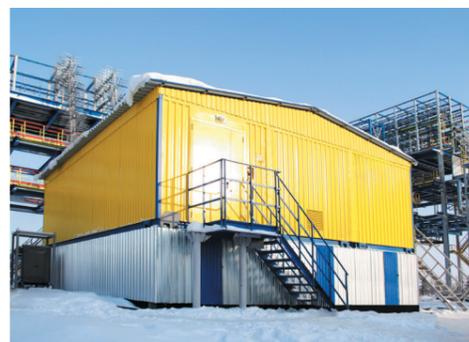
Рис. 4. Пример БКТП-ELM-10 (6)/0.4 в здании из профилированного стального листа
