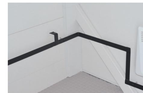
Рис. 9. Внутренний контур заземления
