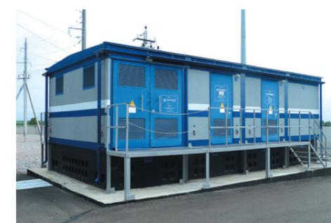
Рис. 2. Примеры БКТП-ELM-10 (6)/0.4 (0.69) в здании из «сэндвич»-панелей и в железобетонном здании
