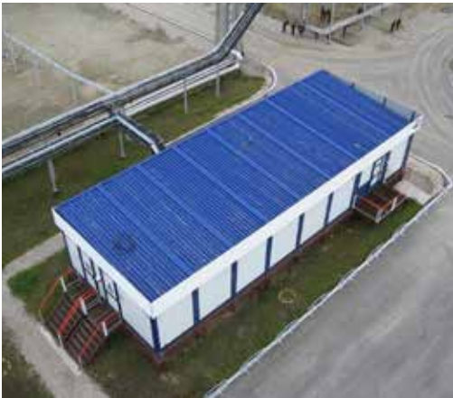
Рис. 2. Пример конструкции металлического БМЗ, обшитого сэндвич-панелями
