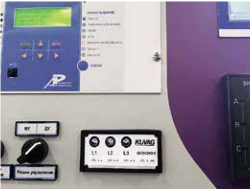
Рис. 28. Индикатор наличия напряжения в составе шкафа КРУ «Элтима»
