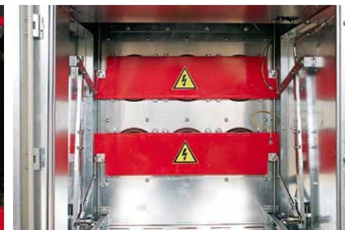
Рис. 20. Шторочный механизм в отсеке КВЭ
