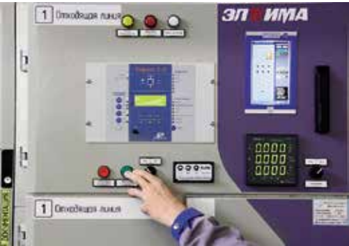
Рис. 27. Отсек вспомогательных цепей
