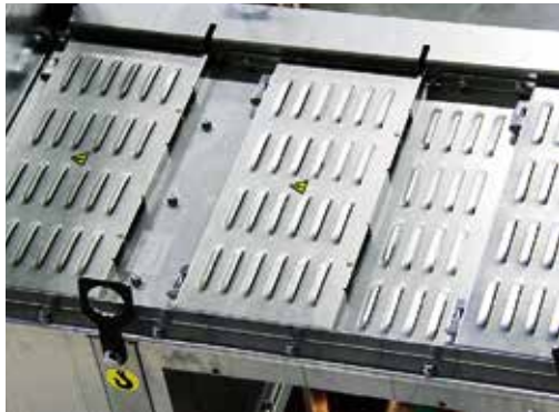
Рис. 26. Клапаны сброса давления
