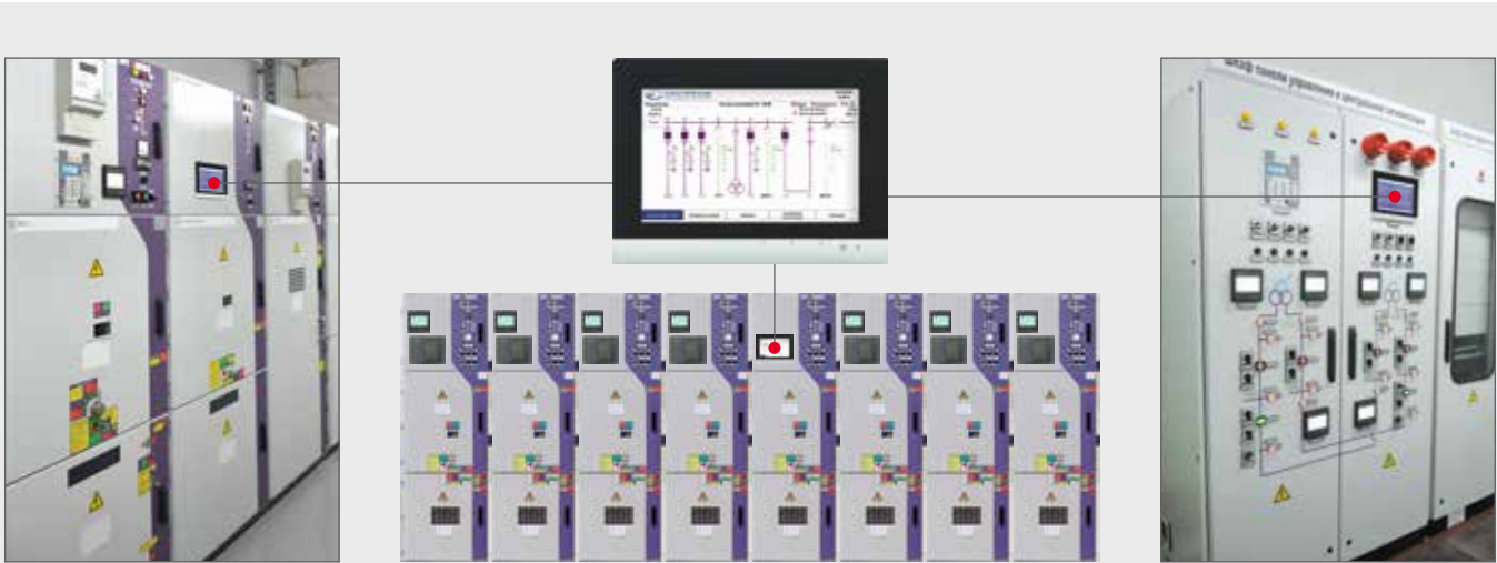
Рис. 36. КРУ «Элтима», оснащенная системой мониторинга и управления с локальной панелью визуализации
