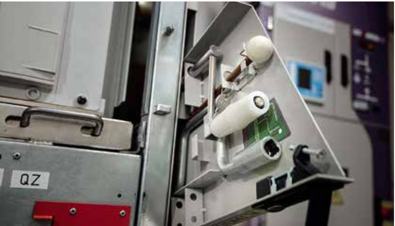
Рис. 37. Рукоятки перемещения КВЭ, заземлителя и ручного отключения выключателя
