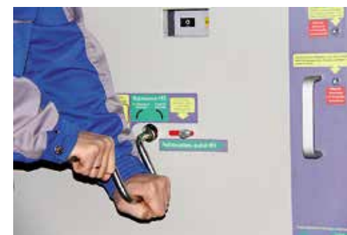
Рис. 19. Перемещение КВЭ внутри отсека
