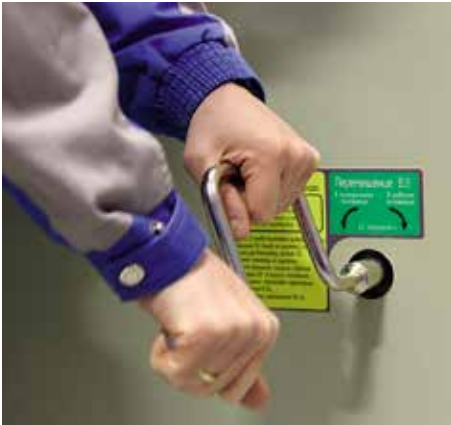
Рис. 10. Перемещение ВЭ внутри отсека
