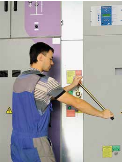
Рис. 12. Оперирование заземлителем
