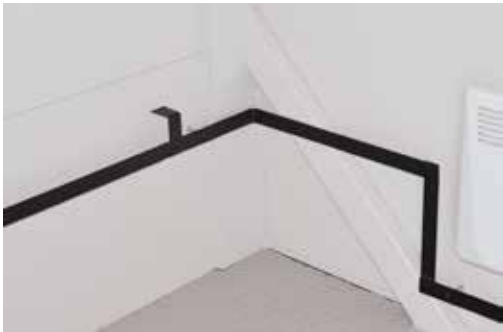
Рис. 9. Внутренний контур заземления
