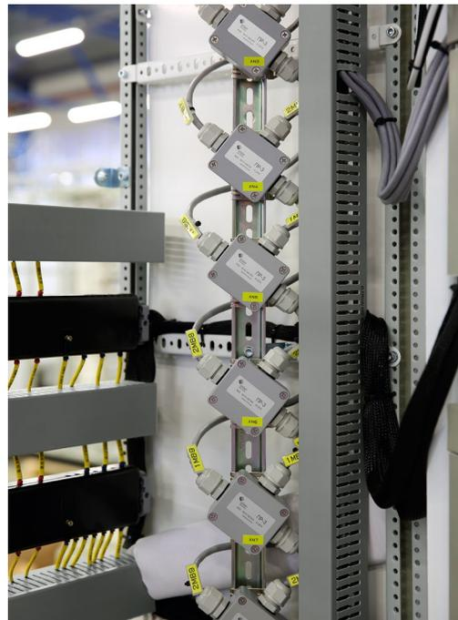
Рис. 39. Организация шины RS-485 с применением разветвительных коробок
