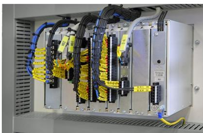
Рис. 16. Цепи терминала МП РЗА
