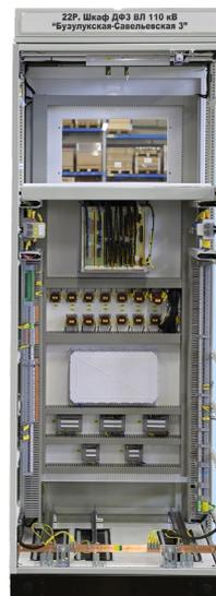
Рис. 23. Пример шкафа ДФЗ линии с разделением на отсеки (вид сзади, во время монтажа)
