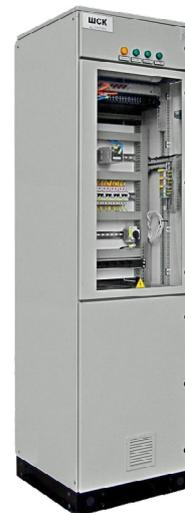
Рис. 35. Пример шкафа сетевых коммуникаций
