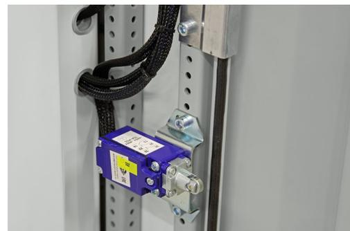
Рис. 3. Концевой выключатель освещения в шкафу
