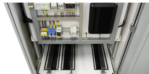
Рис. 10. Зона ввода кабеля в шкафу РЗА
