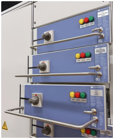
Рис. 10. Положения ВУМ в шкафу
