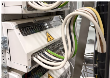
Рис. 11. Подключение кабелей к фиксированным модулям при виде внутреннего разделения 4b
