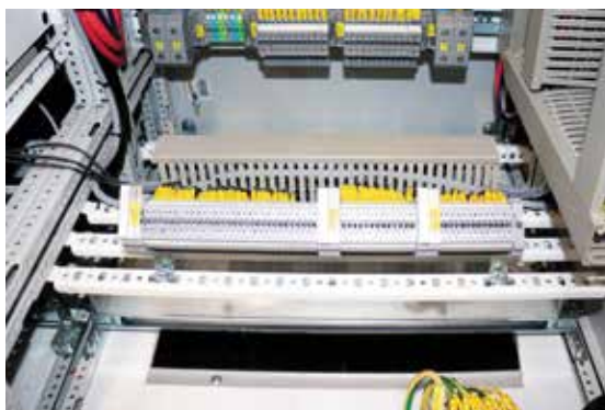
Рис. 2. Пример расположения клеммников для подключения внешних кабелей
