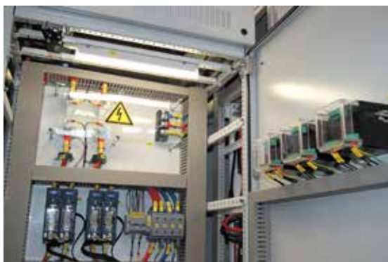
Рис. 3. Защита от прикосновения к токоведущим частям
