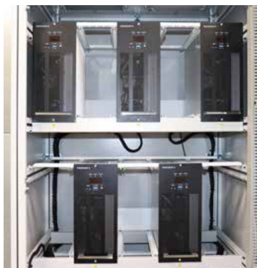
Рис. 9. Транзисторные выпрямительные модули
